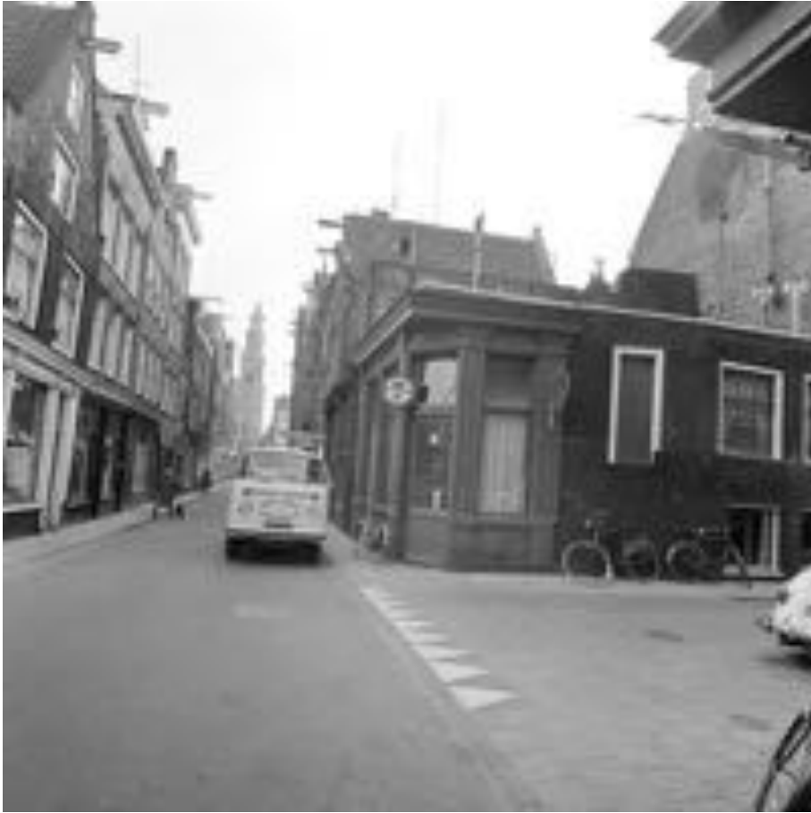
onderstuk 2e Egelantiersdwarstraat, 1974
